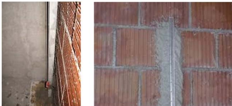
Installazione guide per l'intonaco
