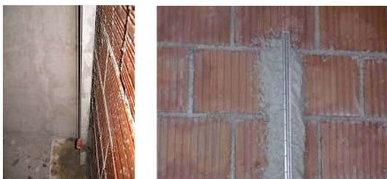
Installazione guide per l'intonaco
